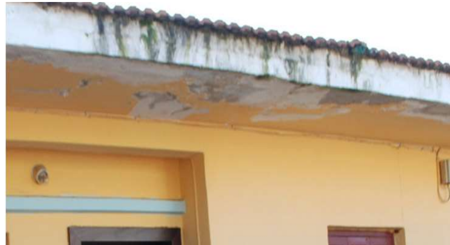
Οξείδωση οπλισμού και διάβρωση σκυροδέματος/ Βλάβες στα επιχρίσματα
