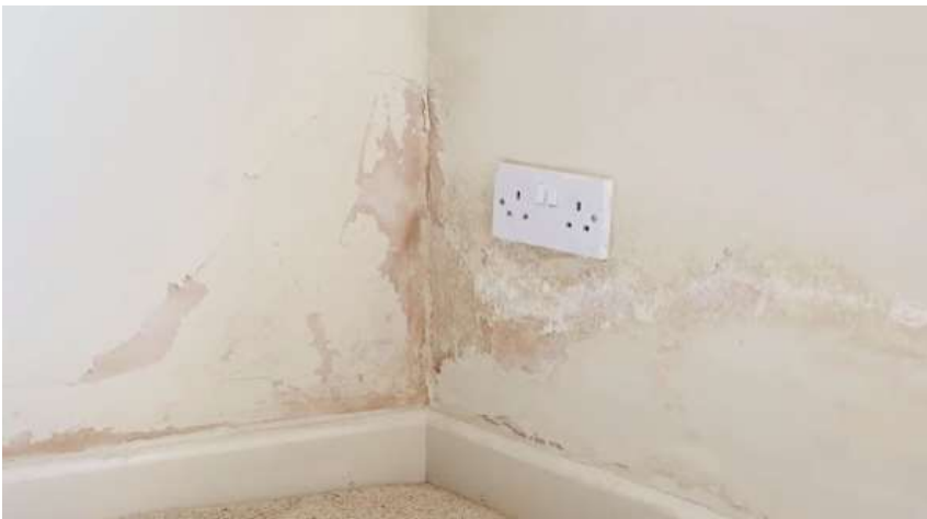
Οξείδωση οπλισμού και διάβρωση σκυροδέματος/ Βλάβες στα επιχρίσματα
