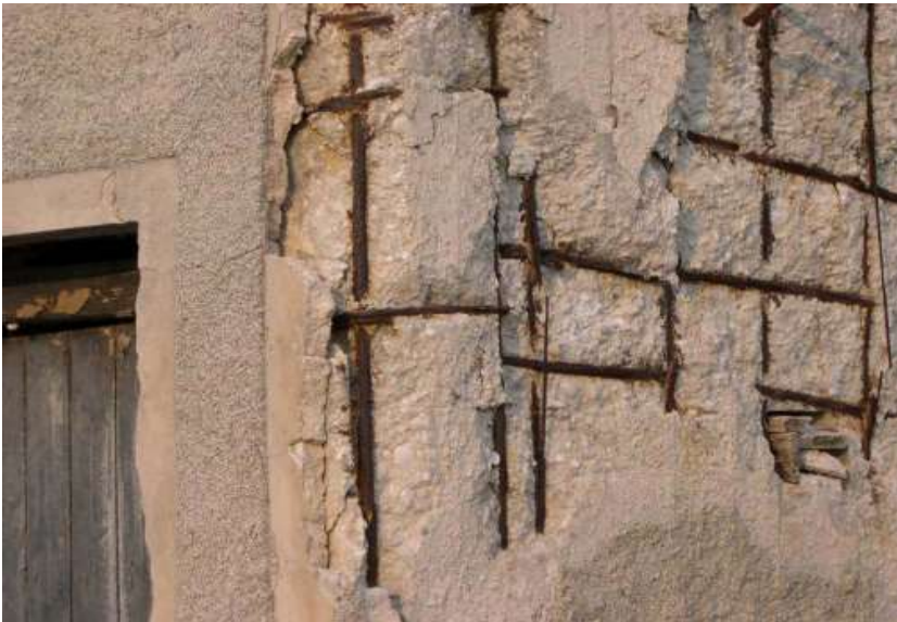
Οξείδωση οπλισμού και διάβρωση σκυροδέματος/ Βλάβες στα επιχρίσματα
