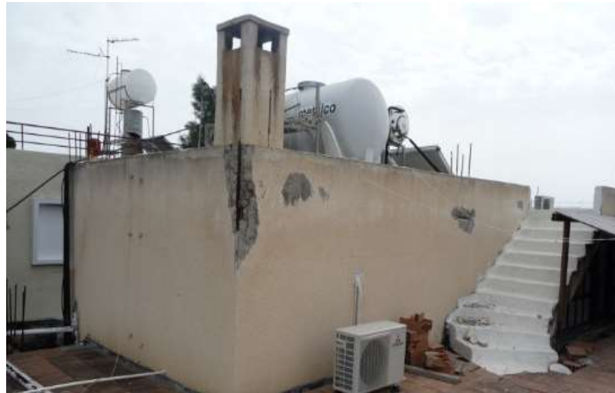
Οξείδωση οπλισμού και διάβρωση σκυροδέματος/ Βλάβες στα επιχρίσματα
