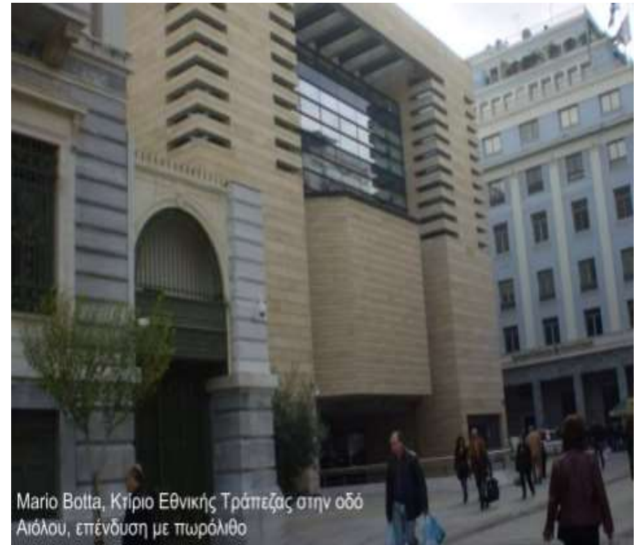
Επένδυση τοίχου με πέτρα
