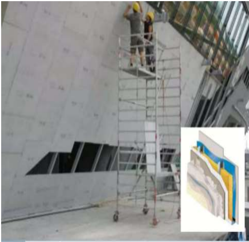
Επένδυση τοίχου με τσιμεντοσανίδες
